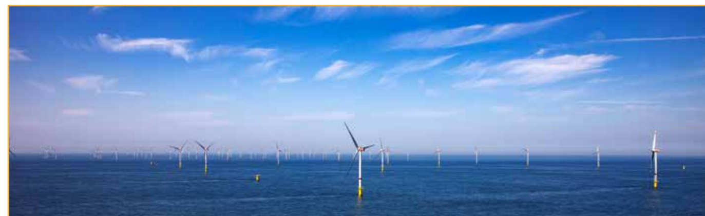
Parc éolien offshore de Rentel
